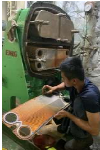
Gambar 2. Pembersihan Kerak Pada Evaporator
