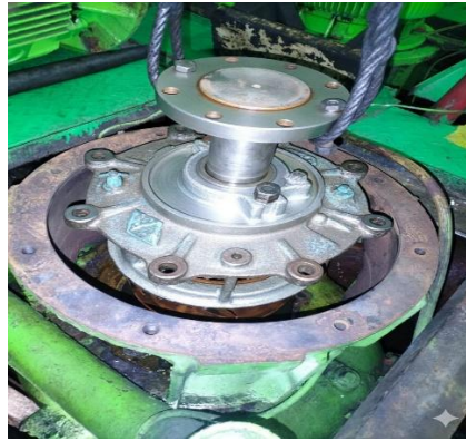
Gambar 5. Pemasangan pompa
