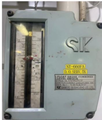
Gambar 1. Float Gauge Sumber : Dokumen Pribadi
