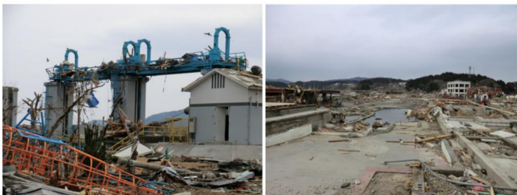
Gambar 9. Gerbang tsunami yang rusak di kota Minami-Sanriku dan kondisi kota setelah tsunami
