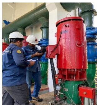
Gambar 3. Pengukuran Vibrasi pada Motor Pompa Air.
