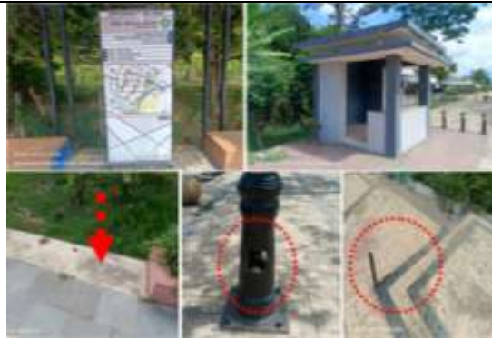
Gambar 17. Map dan posjaga (atas), perbedaan ketinggian (kiri bawah), penutup lampu rusak (tengah bawah) dan besi di tengah trotoar (kanan bawah).
