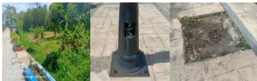
Gambar 4. Perbedaan ketinggian trotoar (kiri), penutup kabel listrik (tengah) dan lubang di tengah trotoar (kanan)
