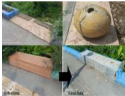
Gambar 6. Bangku beton hilang (atas kiri), Banku bulat lobang (atas kanan) dan lapisan bangku hilang (bawah)
