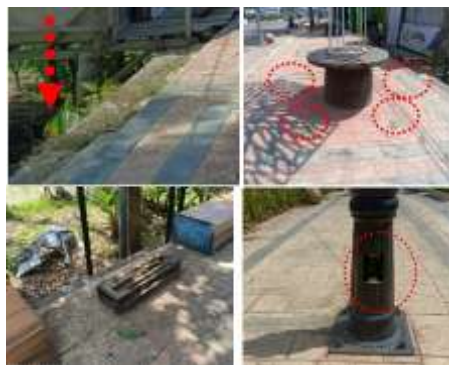
Gambar 23 Perbedaan ketinggian trotoar (kiri atas), besi bekas tempat duduk (kanan atas), besi bekas tempat duduk panjang (kiri bawah), tempat listrik yang terbuka (kanan bawah)
