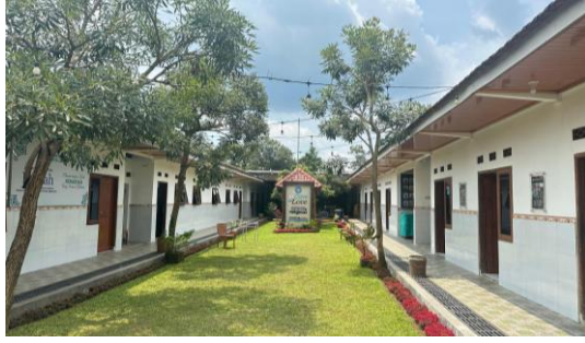
Gambar 1. Kondisi Griya Lansia Husnul Khatimah
