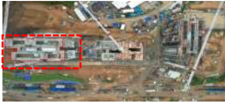
Gambar 2. Tampak Atas Tower Rumah Susun
