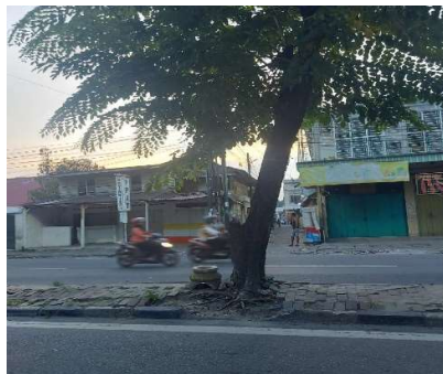
Gambar 4 Pohon Merusak Trotoar atau Median Jalan
