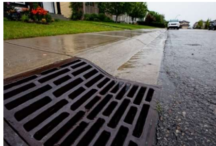
Gambar 2 Drainase Saluran Tertutup
