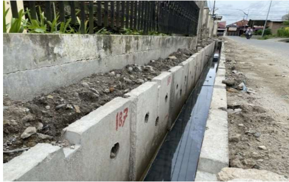
Gambar 1 Drainase Saluran Terbuka
