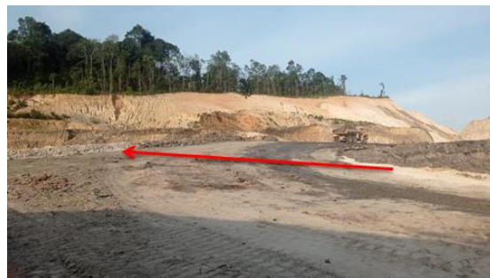
Gambar 5. Superelevasi Pada Jalan Tikungan
