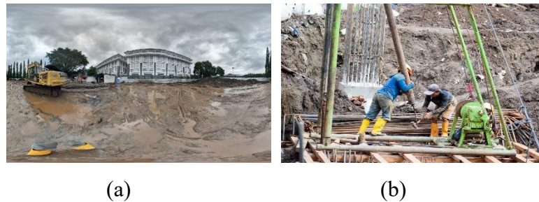
Gambar 1. Kondisi Lapangan pada Pekerjaan Struktur Bawah: (a) Genangan Lumpur di Area Fondasi, (b) Pengeboran Ulang Titik Fondasi
