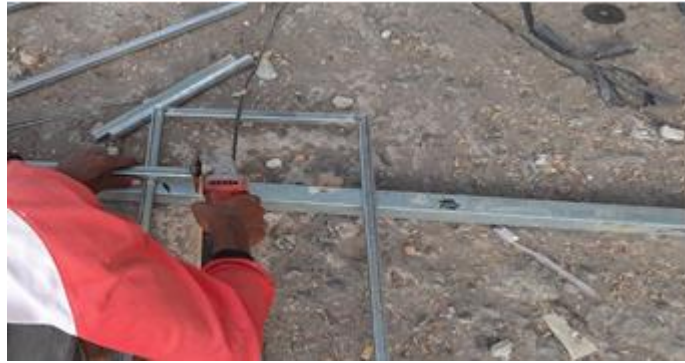
Gambar 4 Proses Pengukuran & Pemotongan Besi Hollow
