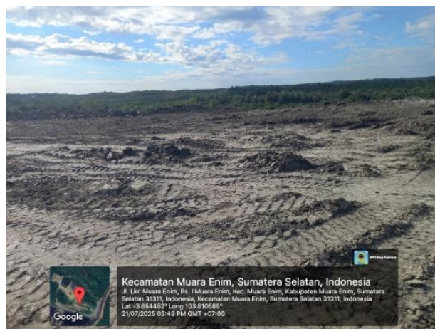
Gambar 5. Jalan hauling yang tidak rata dan bergelombang.
