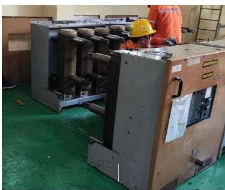
Gambar 4. Kondisi Saat PMT Dibersihkan.
