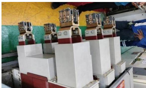
Gambar 5. Kondisi Saat PMT Sesudah Dibersihkan.
