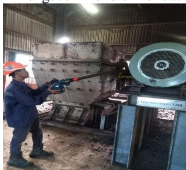
Gambar 20. Membersihkan dan Mengecek Kondisi Pondasi pada Motor Listrik
