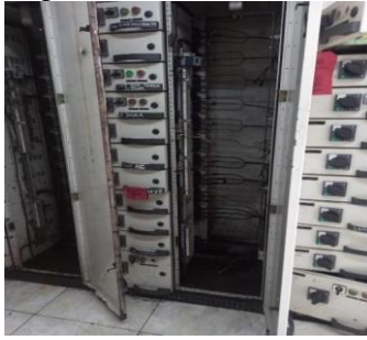
Gambar 21. Mengecek Kondisi Grounding
