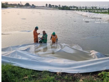
Gambar 2. Pemasangan Geotekstil
