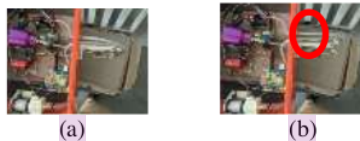
Gambar 13 Pengujian rudder (a) kondisi normal (b) kondisi berbelok Sumber : Dokumentasi pribadi (2024)
