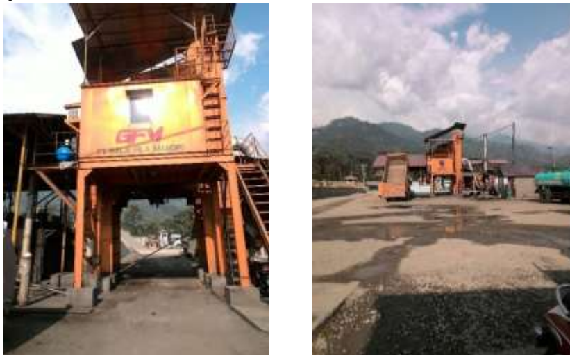
Gambar 2. Lokasi quarry Desa Kandang Mbelang, Aceh Tenggara
