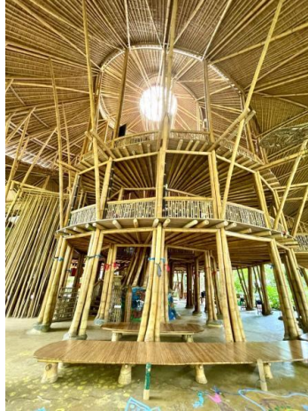
Gambar 7. Atap pada bangunan green school bali
