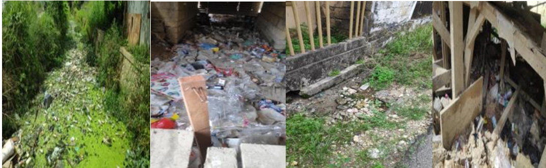
Gambar 4 Indikator Permasalahan Drainase
