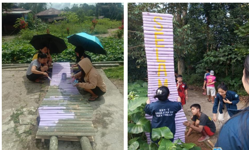
Gambar 7. Proses Pembuatan dan Pemasangan Gapura
