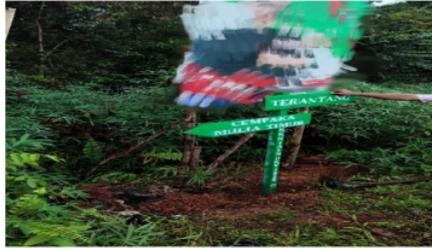
3. Menutup lubang menggunakan pasir yang dipadatkan, agar nantinya plang dapat berdiri dengan tegak dan tidak mudah roboh.
